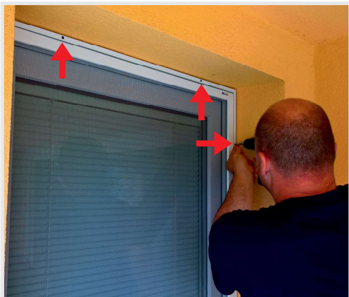
Obr.č.25: Postupne priskrutkujeme všetky skrutky cez predvŕtané otvory na ráme dverovej siete. Ideálne začať na protiľahlej strane oproti stredovému pántu, aby sme zamedzili následnému pohybu siete po nastavení správnej polohy.
