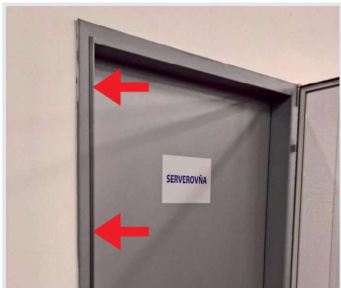
Obr.č.17: Kídlo siete zavrieme. Silnejšie popritláčame kídlo siete o rám dverí, aby sa pevne prilepila obojstranná páska magnetu. Ešte pred prilepením magnetu odmastíte rám dverí. A máme hotovo!
