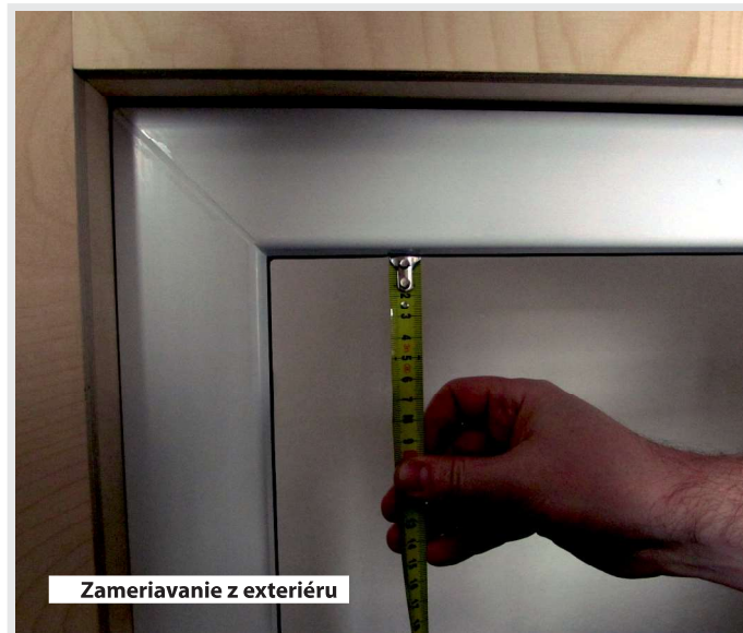
Obr.č.6: Zameranie výšky - názorná ukážka pri zameriavaní s otvorenými dverami. Pri zameraní dbáme na to, aby sme mali zvinovací meter opretý o rám dverí.
