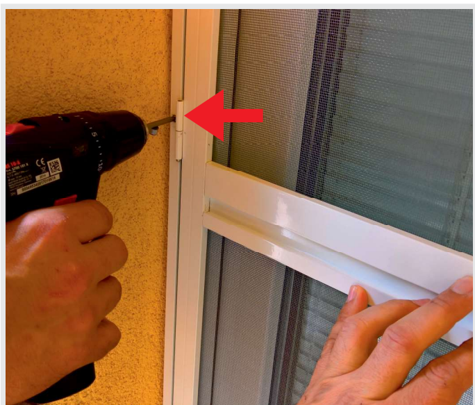
Obr.č.23: Najskôr si nastavíme (vymeriame) približnú polohu siete na ráme dverí a následne priskrutkujeme cez otvor pri stredovom pánte jednu skrutku - nedoťahujeme na doraz!
