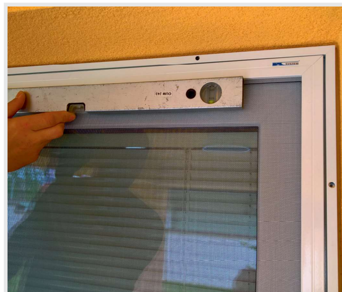
Obr.č.24: Pomocou vodováhy nastavíme sieť do vodorovnej polohy. Prípadne skontrolujeme lícovanie rámu siete s rámom dverí.
