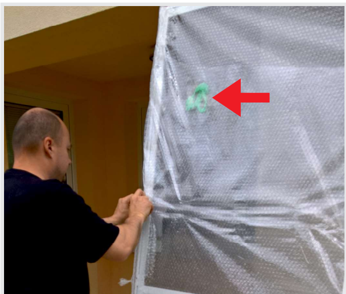
Obr.č.21: Dodanú dverovú sieť vybalíme z bublinkovej fólie a priložený montážny materiál si pripravíme tak, aby sme ho mali po ruke počas montáže. (Označený šípkou na orážku).
