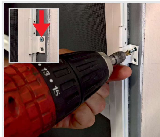
Obr.č.12: Následne priskrutkujeme jednu skrutku pánt o rám dverí. Druhú skrutku naskrutkujeme po vystredení siete a namontovaní ostatných pántov. Umožní nám to dodatočne doľadiť polohu siete vo zvislej polohe.
