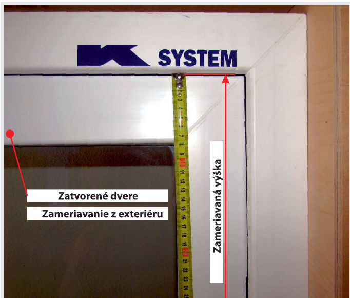
Obr.č.5: Zameranie výšky svetlosti otvoru z exteriéru. Zameriavať je možné aj pri zatvorených dverách, ako je uvedené na obrázku.
