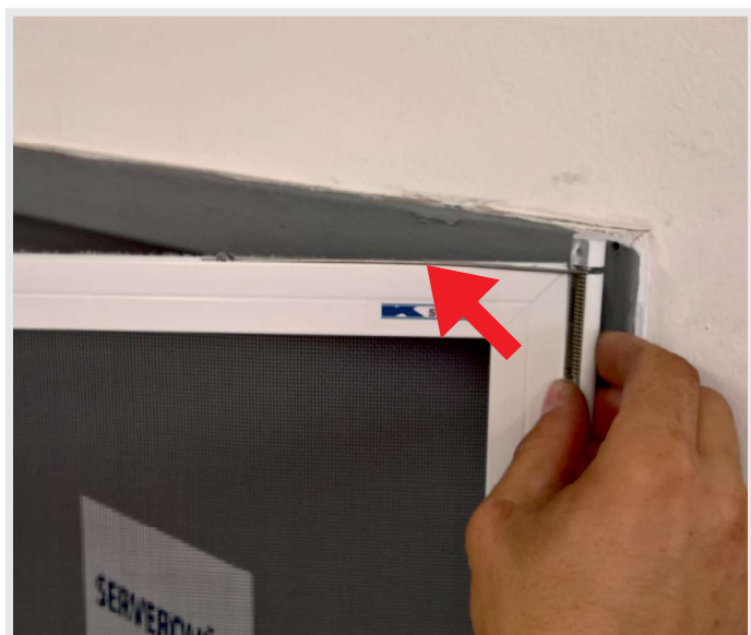
Obr.č.19: Časť pružiny samozatvárača nasunieme do predpripravenej skrutky s otvorom, ktorá je naskrutkovaná na hornú časť rámu dverovej siete.
