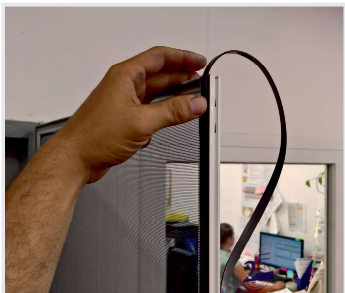
Obr.č.15: Na stranu krídla oproti pántom priložíme druhú časť magnetu (negatív) po celej výške. Magnet je súčasťou príbalového materiálu. Následne magnet skrátime podľa dĺžky magnetu v ráme siete (pozitív). Magnet necháme na dverovej sieti.
