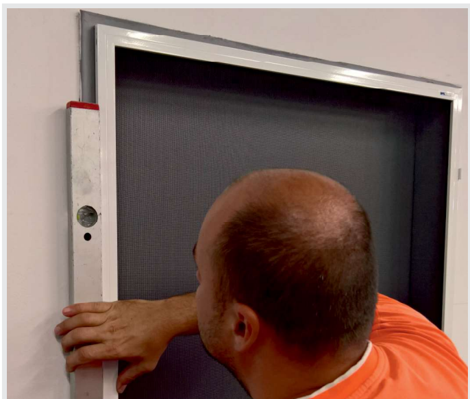
Obr.č.13: Vodováhou nastavíme správnu vodorovnú resp. zvislú polohu krídla siete.
