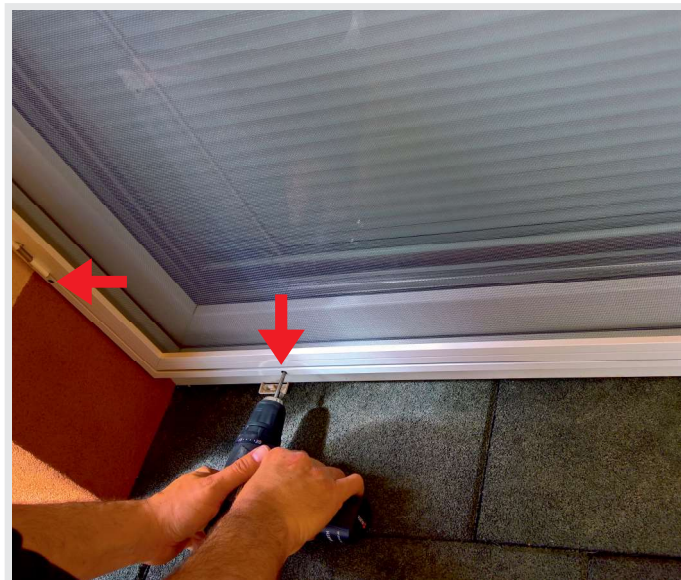
Obr.č.26: Postupne priskrutkujeme všetky skrutky cez predvŕtané otvory na ráme dverovej siete.
