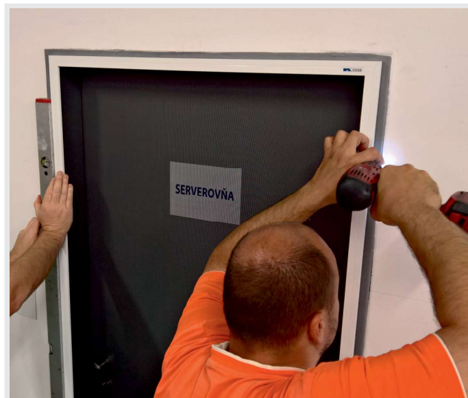
Obr.č.14: Postupne priskrutkujeme všetky skrutky na pánty. Každý pánt (štandardne sú tri) má pridelené 2 skrutky. Druhá osoba nám môže pomôcť pri montáži siete, aby sa zamedzilo pohybu siete.
