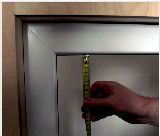
Obr.č.7: K nameranej hodnote výšky pripočítame 2x 25mm. Ak je zameraná hodnota napr 2200mm, pripočítame 2x25mm a dostaneme hodnotu 2250mm , ktorú zapíšeme do objednávky.
